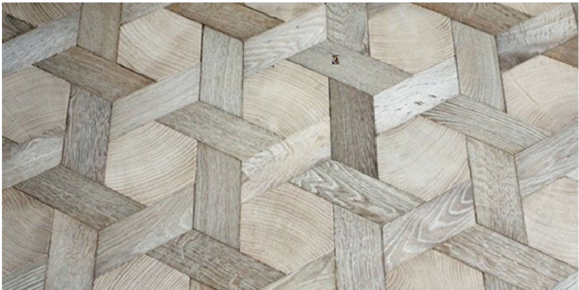
Flechtboden: Durch nebeneinander paralleles Anbringen von Stäben und Drehung entsteht eine Flechtoptik. Auch zueinander verschobene Würfel.
