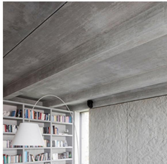
Rippenplatten-Deckenelement in der SBCZ Materialsammlung und in verbautem Zustand
