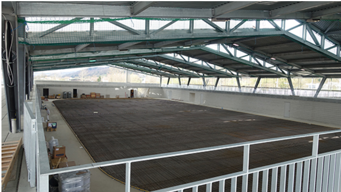
Baustelle Eishalle Sportpark Bünz matt, Wohlen, phalt Architekten AG, 2018
