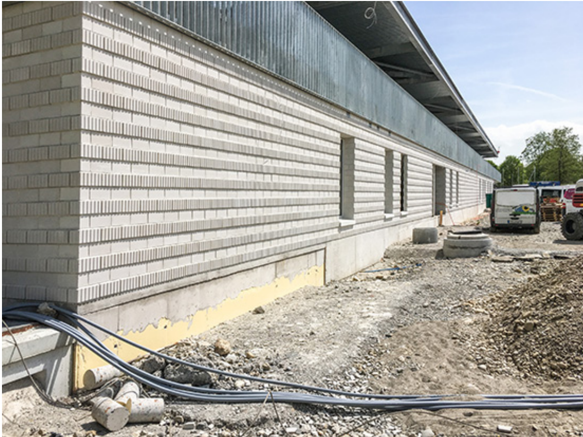
Baustelle Eishalle Sportpark Bünzmatt, Wohlen, phalt Architekten AG, 2018
