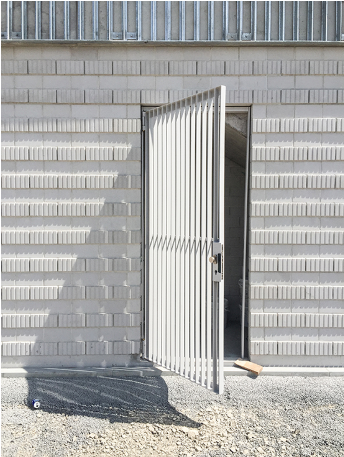
Baustelle Eishalle Sportpark Bünzmatt, Wohlen, phalt Architekten AG, 2018
