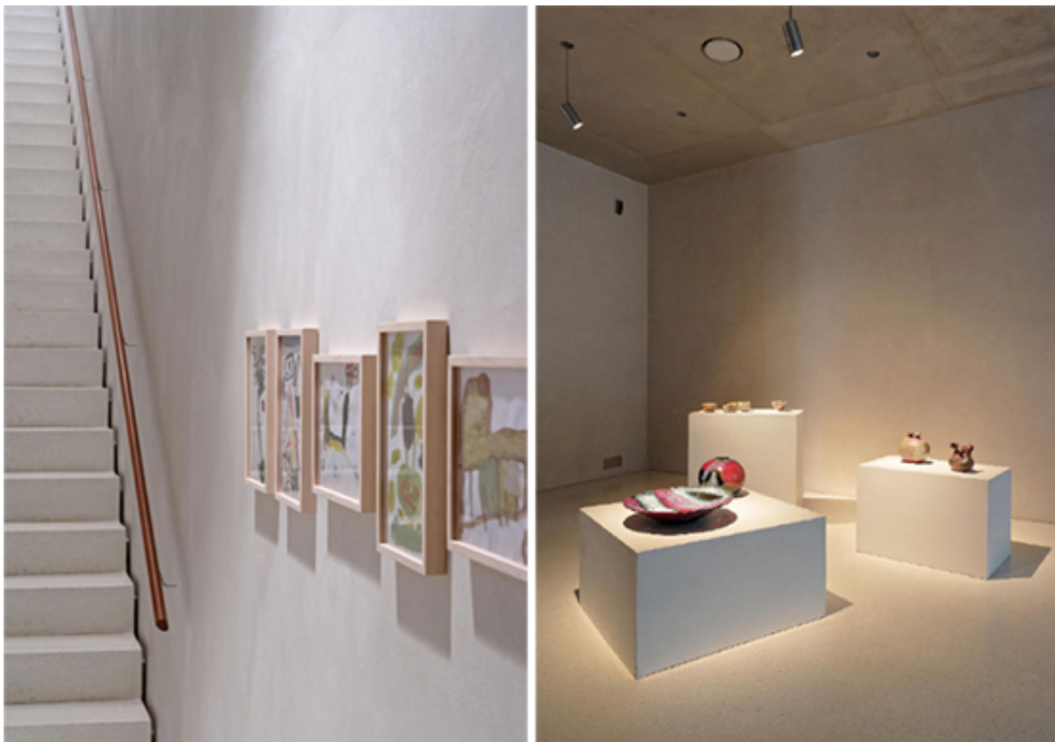
Mit Wasser und Quarkmilch geglätteter Lehmputz von Claytec, Kolumba Museum Köln, Peter Zumthor, 2007
