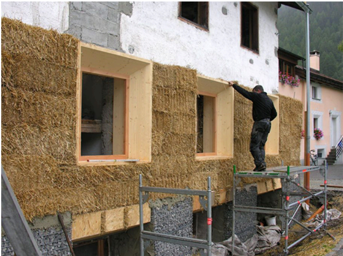
Thermische Sanierung mit Strohbauweise
