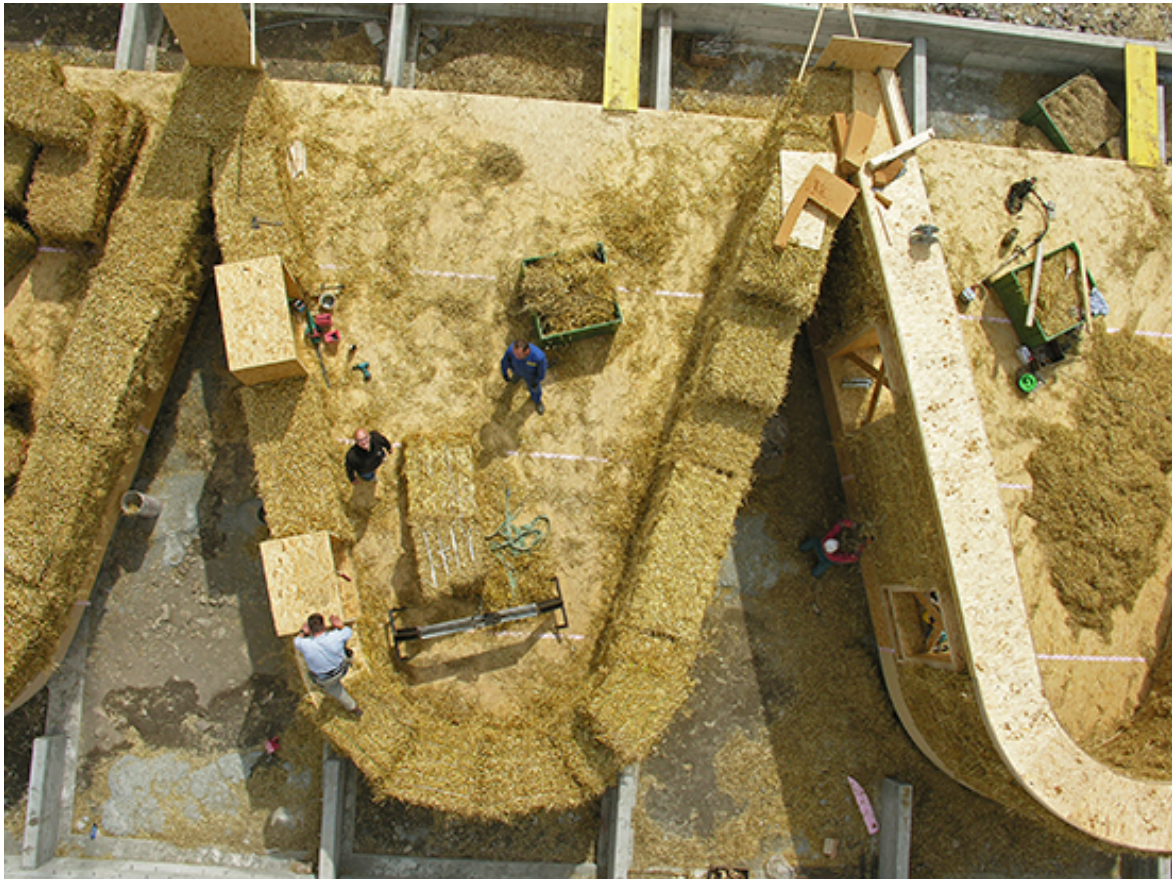
Lasttragende Strohballen beim Projekt Esserhof, Atelier Werner Schmidt, Lana (I), 2006
